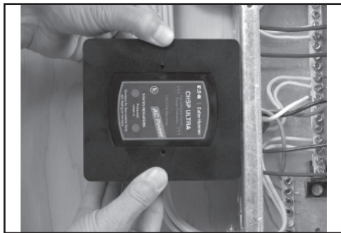
Figure 3. Finished Wall (Flush) Mount/Cubierta para embutir el tablero/Montage encastré dans un mur fini
