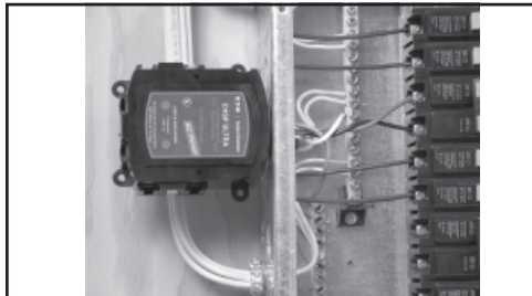
Figure 2. Panel Mount Installation (2)/Instalación en el centro de carga (2)/Installation au panneau (2)
