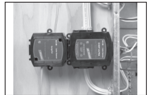
Figure 8. Joining CHSP Modules (2)/Conexión de los módulos CHSP (2)/Jonction de modules CHSP (2)
