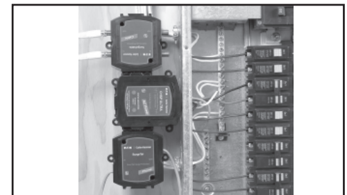
Figure 9. Joining CHSP Modules (3)/Conexión de los módulos CHSP (3)/Jonction de modules CHSP (3)
