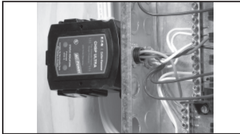
Figure 1. Panel Mount Installation (1)/Instalación en el centro de carga (1)/Installation au panneau (1)
